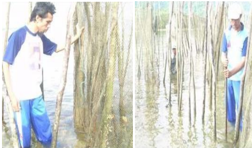
Gambar 3. Proses pemasangan tiang kayu agar kokoh serta tahan terhadap pengaruh angin dan gelombang
